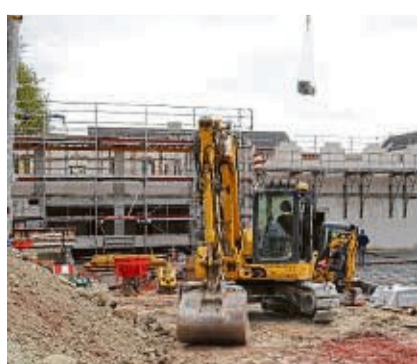
Der neue Dienstsitz der Stadtwerke am Kaltenborn nimmt mehr und mehr Formen an.
